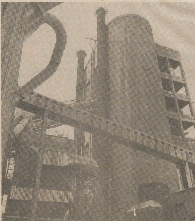
Új, Lurgi típusú porszűrők a beremendi cementgyár kéményein
