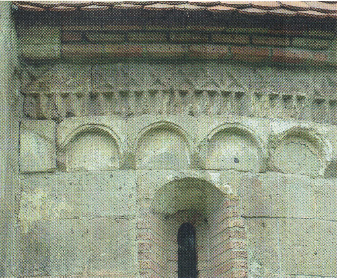
7. kép Teljes ívsoros párkányzat – anastylosis
