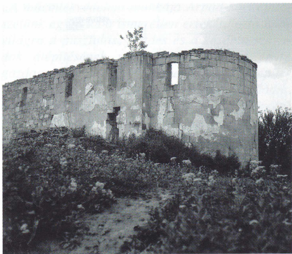
3. kép Talált állapot a leégés után, a helyreállítást megelőző romos állapot
