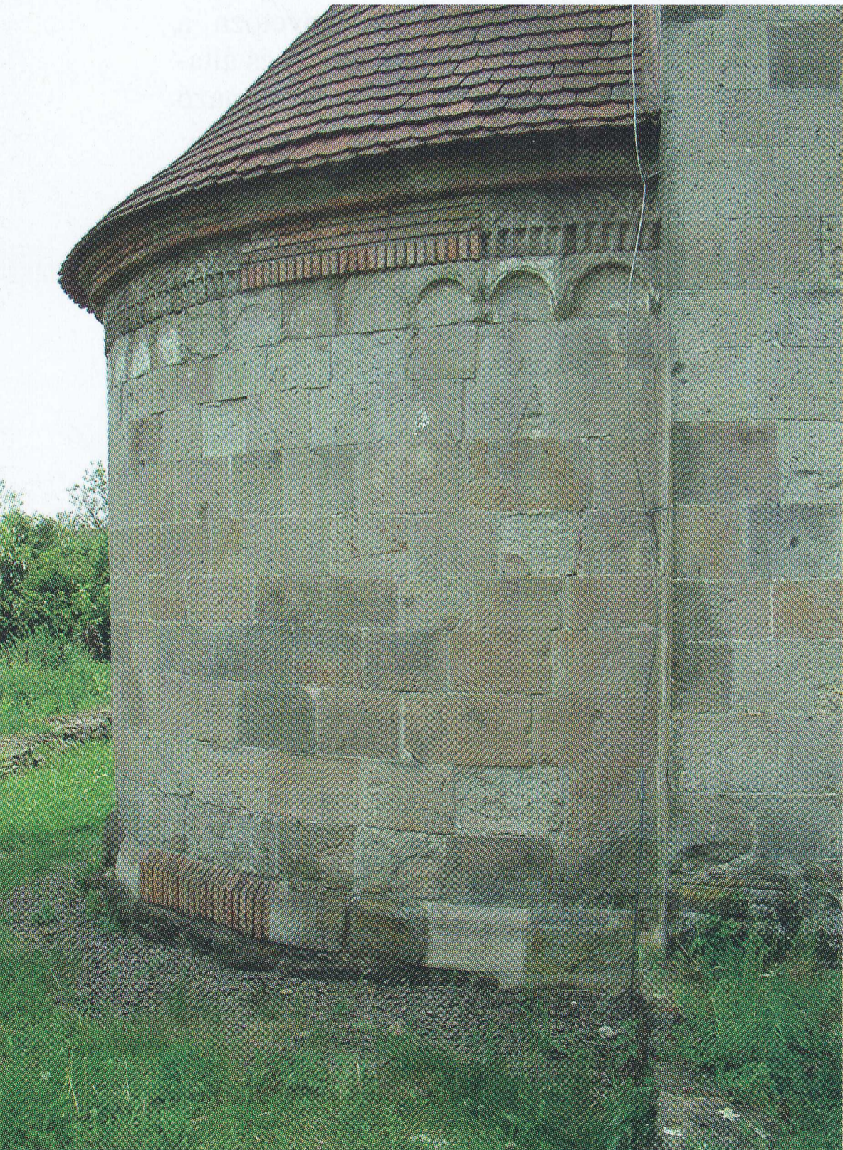
8. kép Lábazat és párkány téglakiegészítéssel
