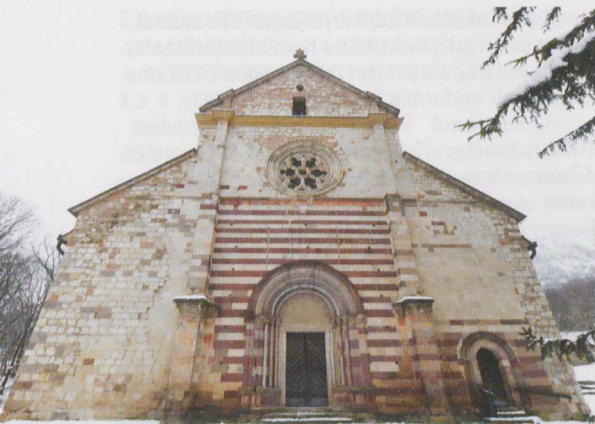
3. kép Bélapátfalva, apátsági templom, nyugati homlokzat. Az apátsági templomról készült fotókat Horogszegi Tamás készítette 2018-ban
