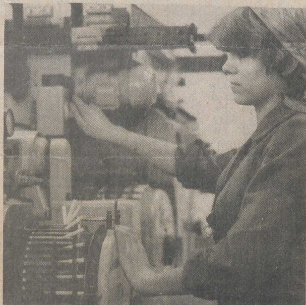
Ez a korszerű gép egyszerre sodorja, tölti, ragasztja és darabolja a cigarettát.
