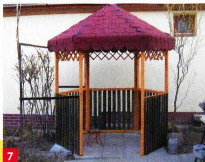
7 Jött a végleges összeállítás és zsindeyezés.
