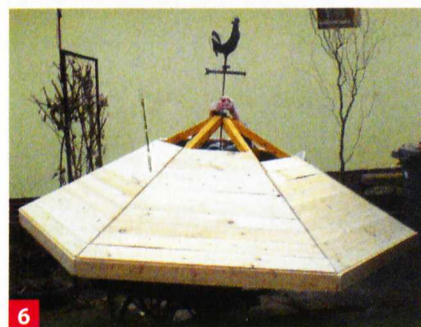
6 A tetőt egyszerűbb volt a földön ledeszkázni.
