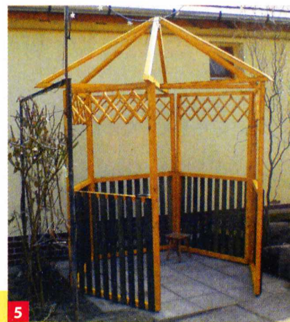
5 Itt már a kész szerkezet ellenőrzése látható.
