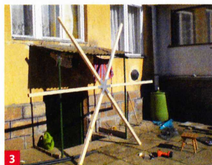
3 Következett a tetőszerkezet összeállítása.
